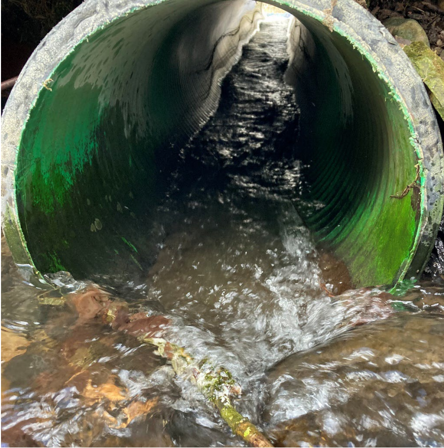
Figur 4. Fald ved indløb i røroverkørslen
